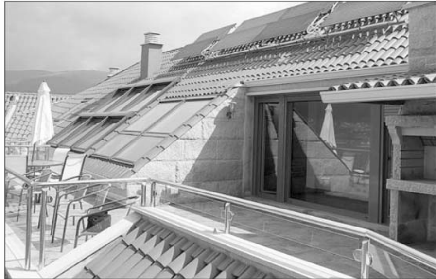
Instalación de paneles para un sistema de energía solar termodinámica.
