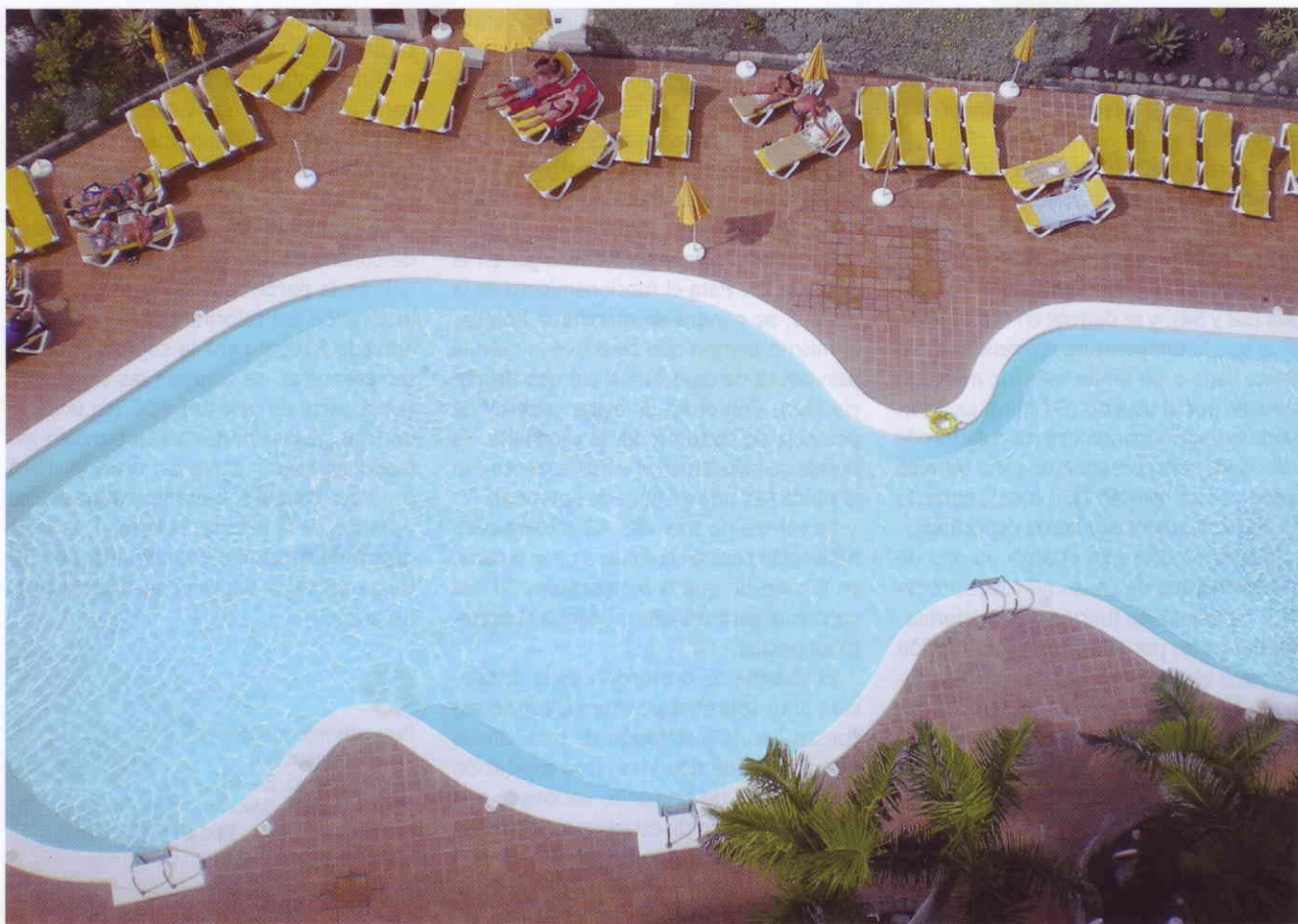
Piscina del hotel Green Beach de Las Palmas de Gran Canaria. 160 paneles calientan su agua.
